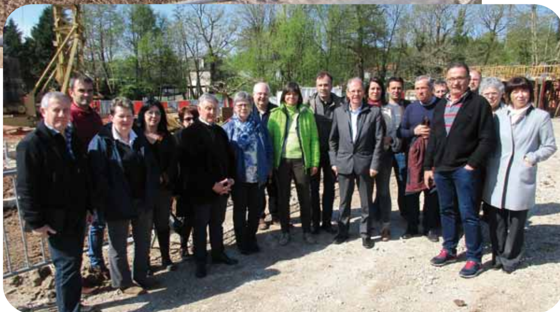
Visite du chantier de l'éco-piscine avec le Conseil Municipal, les agents communaux, l'architecte et les responsables des travaux.
